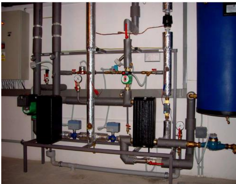
Obr. 18 Schéma tlakově nezávislé předávací stanice Zdroj: AVOS Vyškov, avos.cz
